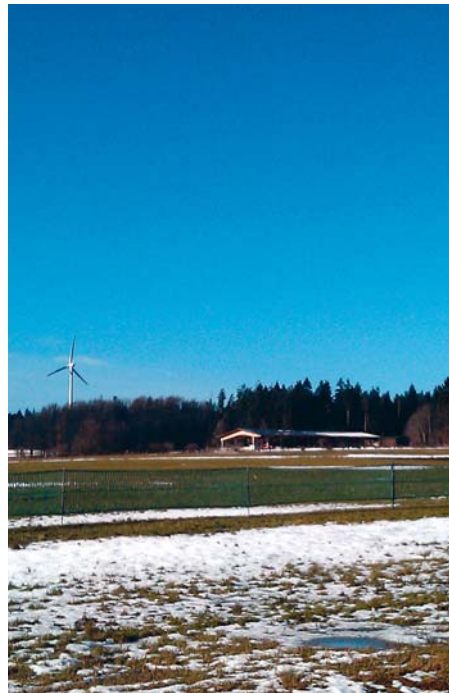
Bestehende Windenergieanlage im Gebiet des Windparks
