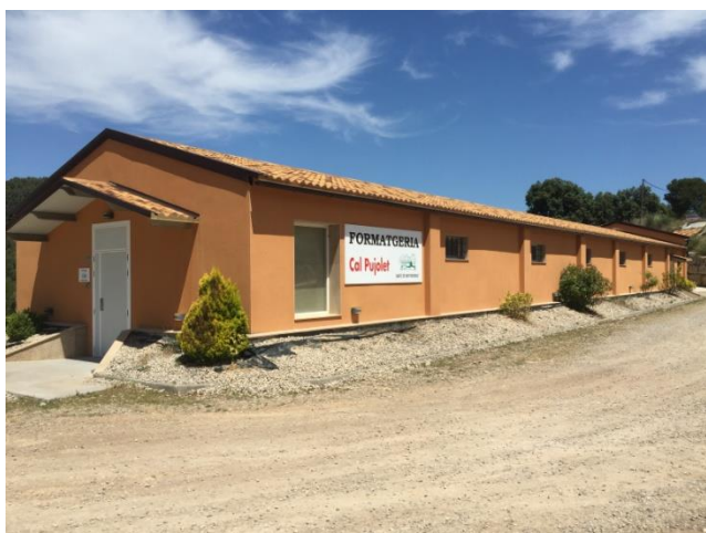
Vue de la fromagerie
